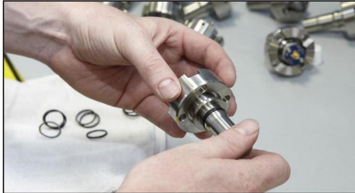
6. Lubrifique o anel de selagem do novo transdutor e o furo na placa inferior com um lubrificante adequado, para garantir que o mesmo não é danificado durante a montagem.
